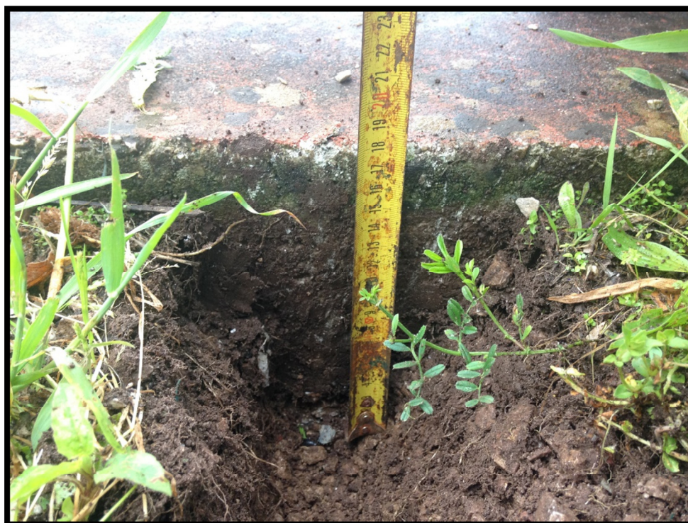
FOTO 5. -Detalle de la actual losa de hormigón
